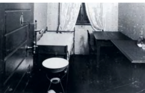
Cellule de la prison de Wronke
