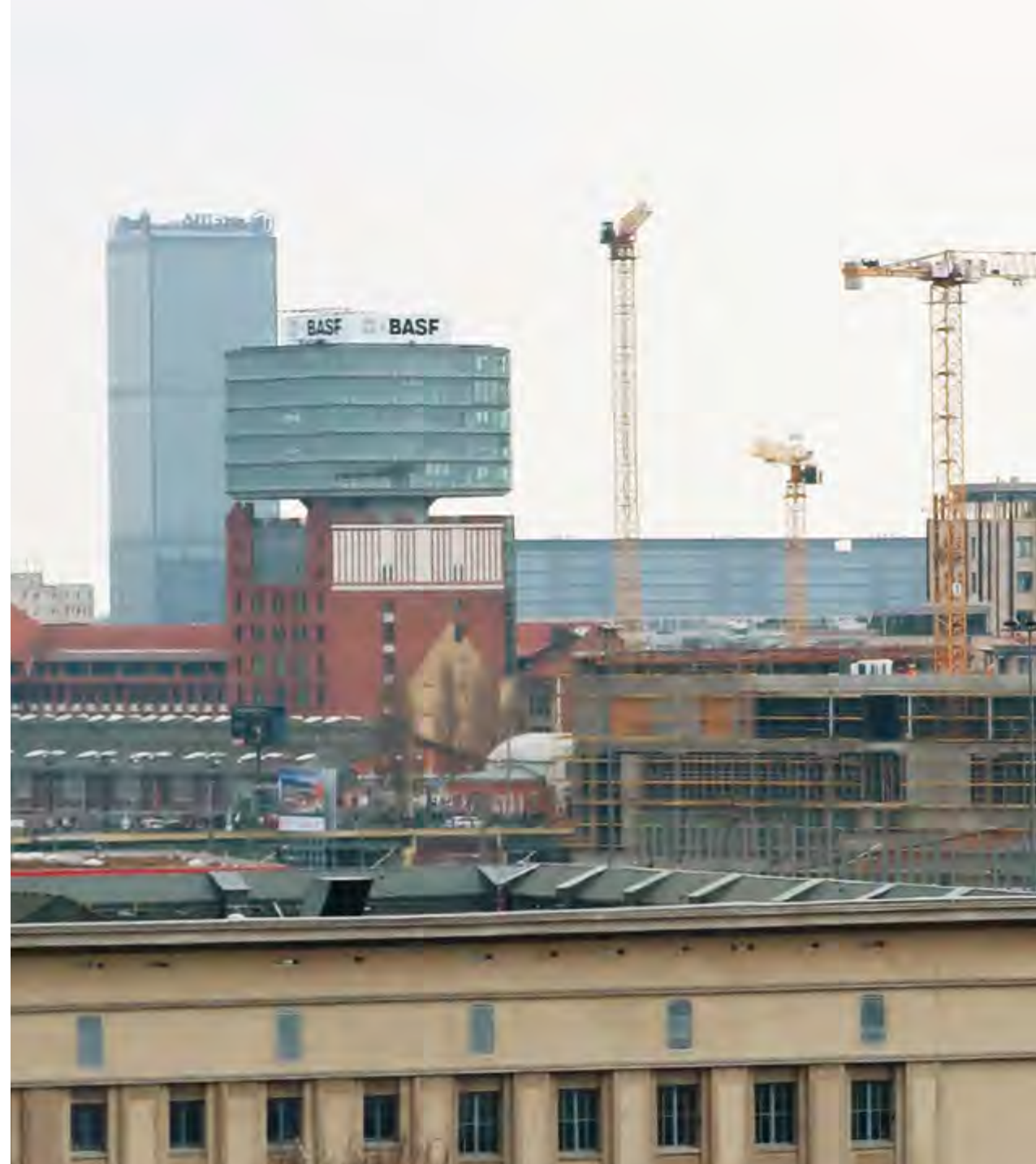
▲ Blick aus der Zentrale der Rosa-Luxemburg-Stiftung auf eine der Berliner Niederlassungen von BASF. Im Hintergrund die Allianz-Versicherung, die ebenfalls zu
